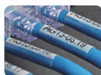
④ケーブルマーキング
